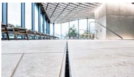
SPArin ist zudem absolut dicht: Sie besitzt integrierte Drainagelöcher im Flanschbereich, die die Dünnbettabdichtung entwässern. So kann sich keine Staunässe bilden.
