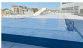
Die Lamellen sind mit Scharnierprofilen ausgestattet, sodass die Abdeckung in einem Schacht hinter dem Becken zu Paketen platzsparend zusammengefaltet wird. Dadurch, dass sie nicht auf eine Welle aufgerollt wird, ist die Länge der Abdeckung praktisch unbegrenzt. Die Faltabdeckung besteht aus robusten PVC-Lamellen mit luftdichten Kammern, die sowohl Auftrieb als auch Isolierung bieten. Das Auf- und Abrollen erfolgt
